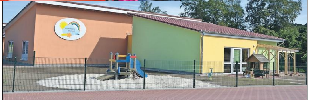
Fertigstellung im Sommer 2019: Neubau der Kinderkrippe „Wolkennest“
